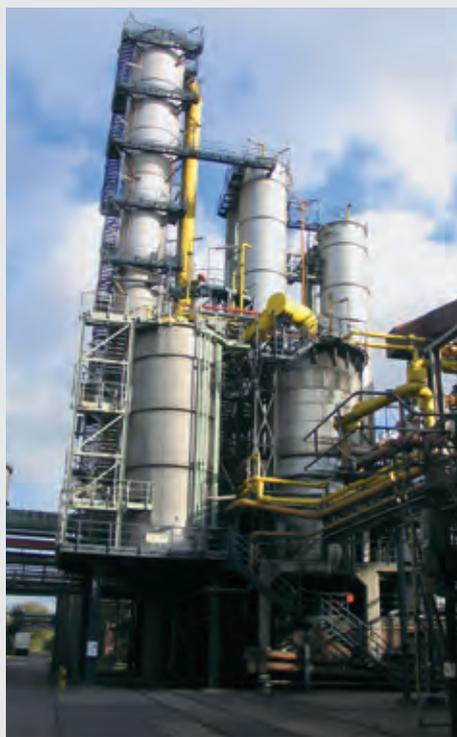
**Die vorhandene Elektroteerfilteranlage und Wascherstraße für das Koksgas hat eine Durchsatzkapazität von 75.000 m<sup>3</sup>/h und wird in etwas größerer Form daneben ein zweites Mal entstehen. Kapazität der neuen Straße: 85.000 m<sup>3</sup>/h**
