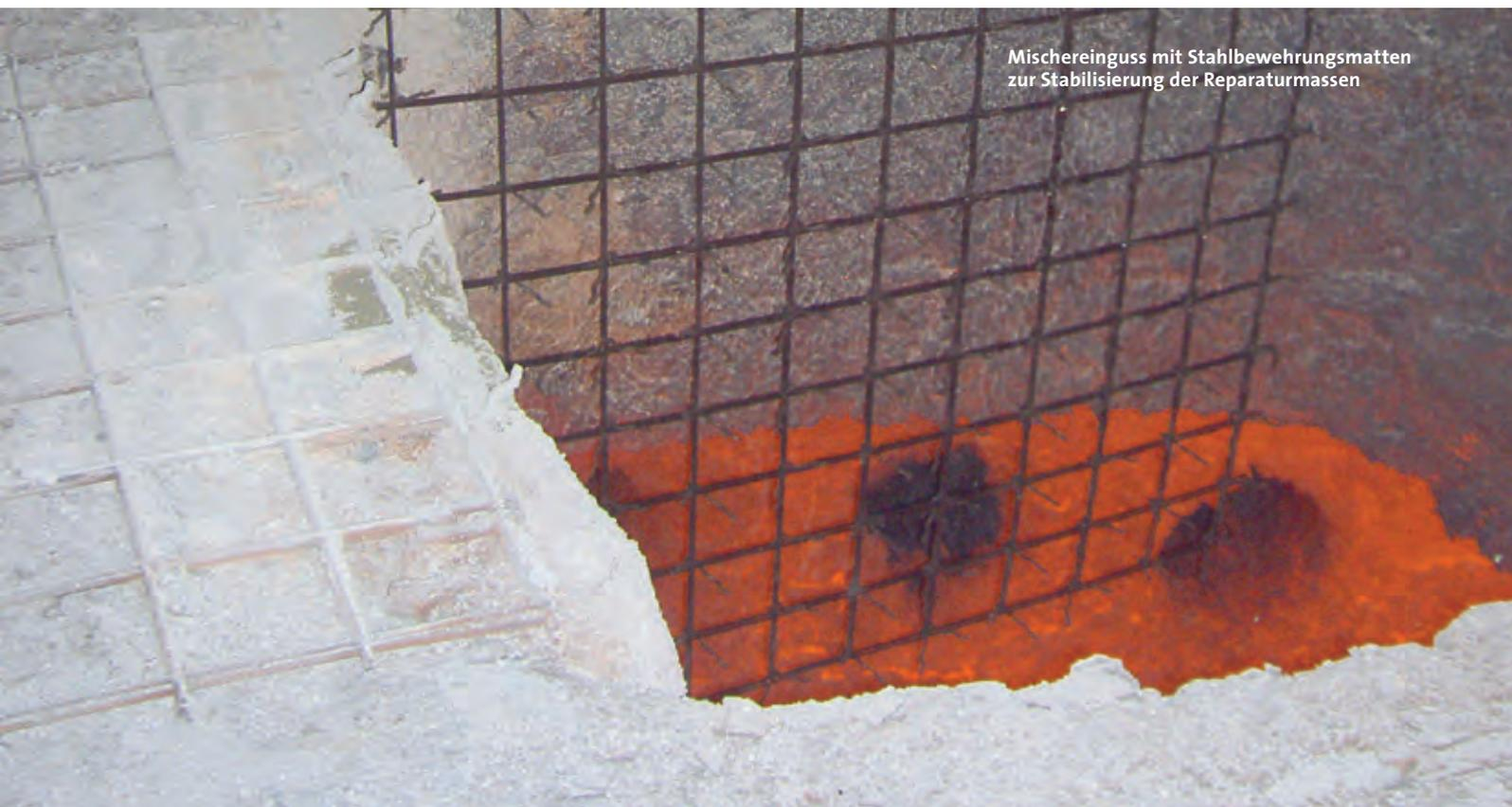
Mischereinguss mit Stahlbewehrungsmatten zur Stabilisierung der Reparaturmassen
