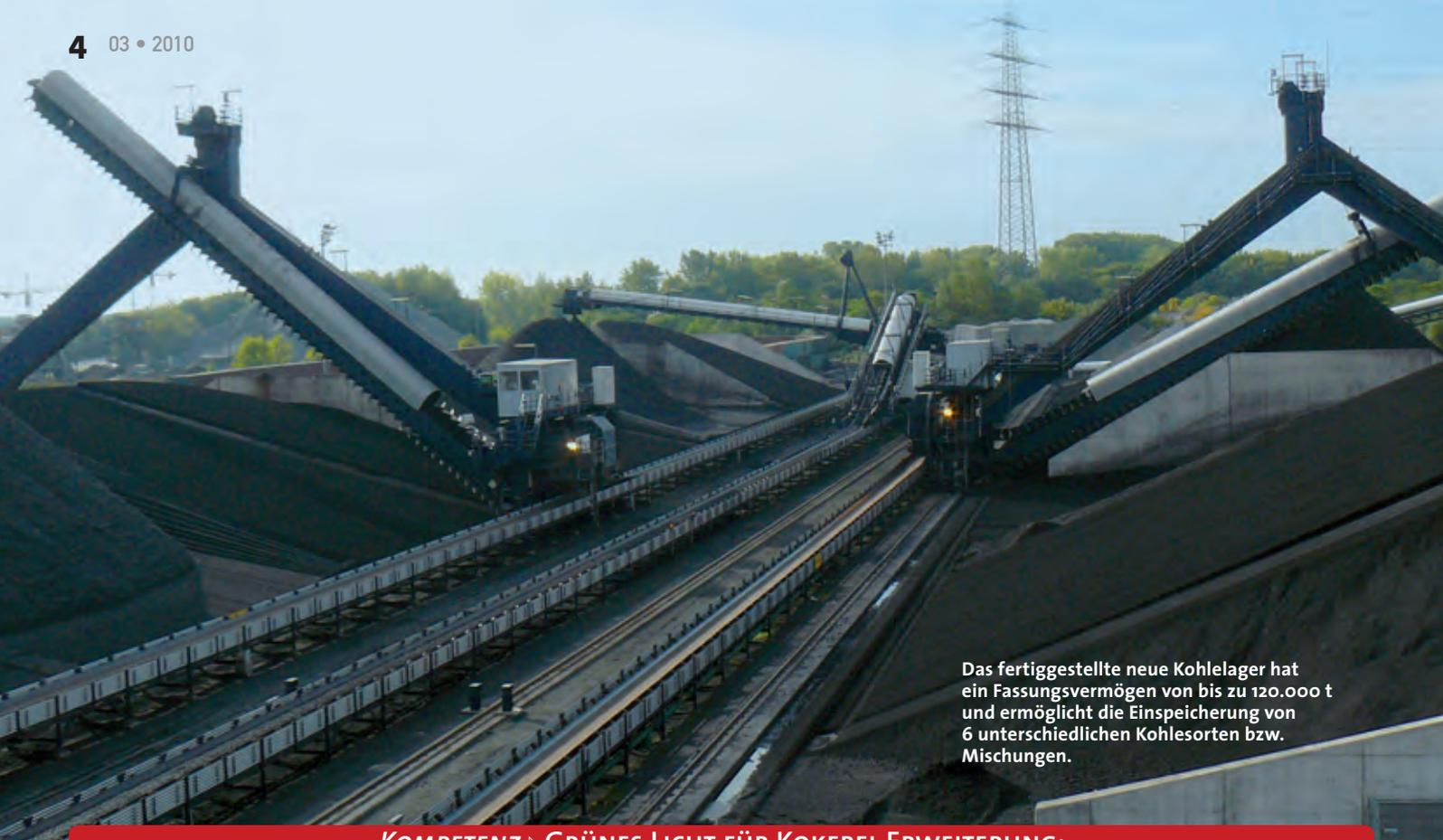
Das fertiggestellte neue Kohlelager hat ein Fassungsvermögen von bis zu 120.000 t und ermöglicht die Einspeicherung von 6 unterschiedlichen Kohlesorten bzw. Mischungen.
