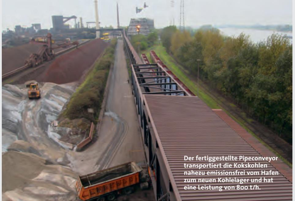
Der fertiggestellte Pipeconveyor transportiert die Koksrohstoffe nahezu emissionsfrei vom Hafen zum neuen Kohlelager und hat eine Leistung von 800 t/h.
