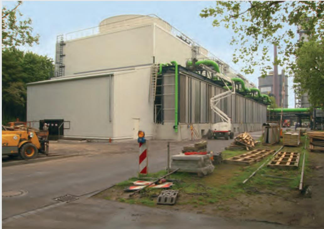
Die neue Wasserwirtschaft der Gasbehandlungsanlagen steht kurz vor ihrer Inbetriebnahme. Im Bild ist der neue aus faserverstärktem Kunststoff hergestellte Ventilatorkühlturm zu sehen. Er hat eine Kühlwasserdurchsatzkapazität von 8.000 m<sup>3</sup>/h.
