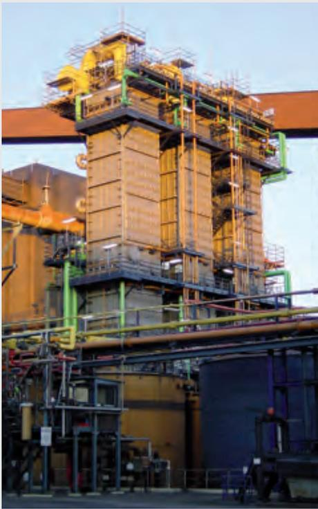
Die in 2008 in Betrieb gegangenen drei neuen Vorkühler werden um zwei weitere Vorkühler direkt neben der vorhandenen Anlage ergänzt, so dass zukünftig bis zu 170.000 m<sup>3</sup>/h Koksgas verarbeitet werden können.
